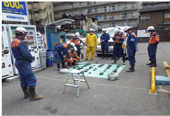
写真3 消防用設備の発掘（感知器）
