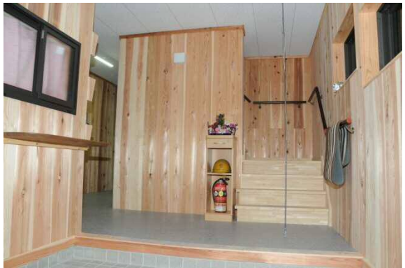
写真6 ホール（出火箇所）
