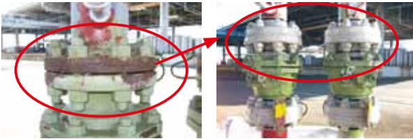
Figure5 開放フランジ部施工前 開放箇所のみ塗布
