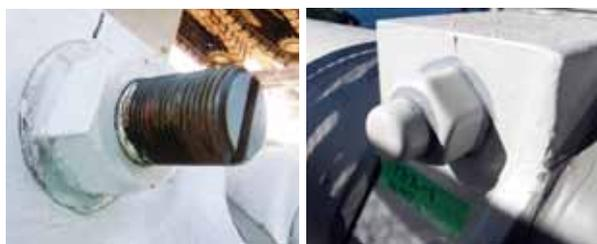
Figure11 左 M42サイズ既存キャップを撤去したところ、一部サビ発生
