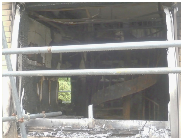
図3 焼損した螺旋階段(7月22日筆者撮影)
